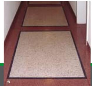
optisch individuell gestaltbar. Durch farbige Gesteinskörnungen wie beispielsweise Marmor oder Kalkstein, Pigmente und weißem Portlandzement können bei Terrazzoböden alle gewünschten Farbgestaltungen erzielt werden. Die Oberfläche wird in der Regel feingeschliffen, kann aber auch gewaschen werden. Durch Trennschienen aus Messing oder farbigem Kunststoff werden die Böden dekorativ in Felder
