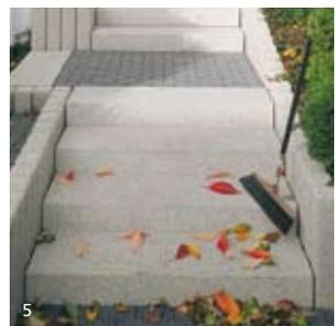
Neue Betontechnologien ermöglichen auch hier den Einsatz immer dünnerer und damit leichter Materialien. So gibt es mittlerweile nicht nur Blockstufen, deren Gewicht um die Hälfte reduziert werden konnte, sondern auch Winkelstufen in einer Dicke von nur noch zwei Zentimetern, die sich wesentlich leichter transportieren
