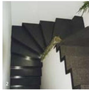
Modernste Verfahrenstechniken und hochleistungsfähige Betone erlauben es, immer dünnwandigere Bauteile herzustellen, die dennoch über höchste technische Qualitäten verfügen, wie z. B. die Biegezugfestigkeit. In Verbindung mit einer Bewehrung lassen sich so auch tragende, filigrane Bauteile ausbilden – oder dünne Winkelstufen, die sich durch extrem feine, porenarme Oberflächen und besonders exakte Kanten auszeichnen.
