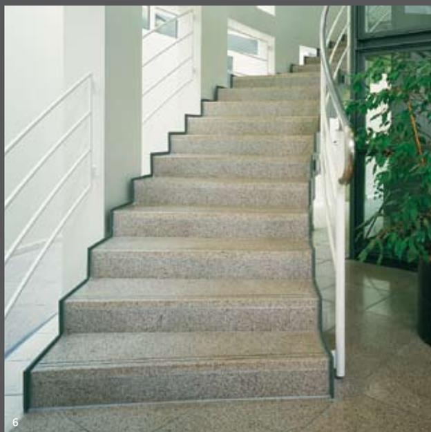
freie Formbarkeit erfüllt der Betonwerkstein jeden gestalterischen Wunsch, von traditionell bis avantgardistisch. Als ansprechende Verkleidung für den massiven Unterbau gilt dies ebenso wie als optische Komponente für freitragende Konstruktionen.
