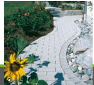
Zunehmend werden auch „veredelte“ Oberflächen in Form imprägnierter, versiegelter oder beschichteter Pflaster und Platten angeboten, die nicht nur leicht zu reinigen sind, sondern auch die Neigung zur Schmutzaufnahme deutlich reduzieren.
