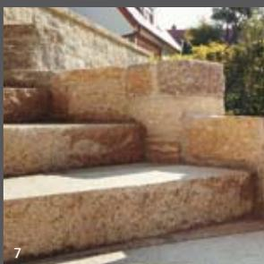
und verlegen lassen. Deshalb eignen sie sich speziell zur Sanierung alter Treppenbeläge, da sie einfach auf den vorhandenen Stufen verlegt werden können.
