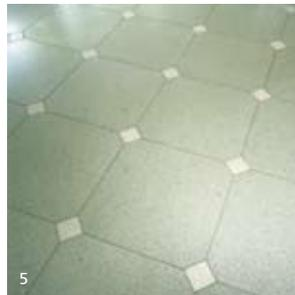
Besonders ideal ist die Kombination von Betonwerksteinbelägen und Fußbodenheizungen.
