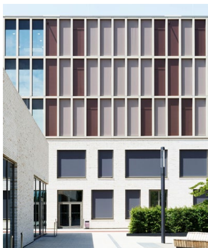
Freising, Grund- und Mittelschule Steinpark, Glasfaserbeton
